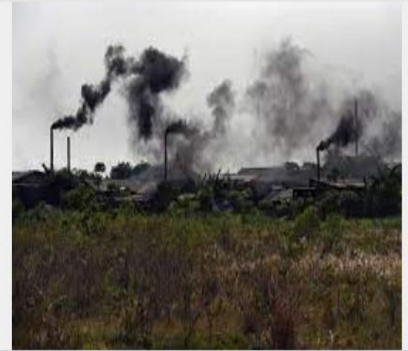
Pabrik Tahu di Sidoarjo Berbahan Bakar Sampah Plastik m.medcom.id
