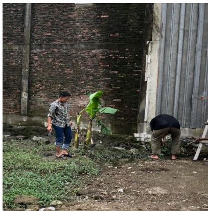
Gambar 1. Kegiatan pemasangan lubang biopori di tanah minim resapan.
