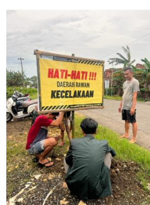
Gambar 5. Pemasangan MMT di beberapa titik.
