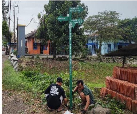
Gambar 6. Pemasangan petunjuk arah jalan.
